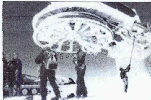
η παρέμβαση έχει χαρακτήρα ανακαίνισης με νέο ηλεκτρικό σύστημα κίνησης, νέο σύστημα αυτοματισμών και ασφαλείας, νέα συρματόσχοινα και λοιπές παρεμβάσεις συντήρησης και ελέγχων. Οι συγκεκριμένοι αναβατήρες βρίσκονται για χρονικό διάστημα μεγαλύτερο της δεκαετίας σε ακίνησία, λόγω σοβαρών τεχνικών προβλημάτων που επιδεινώνονται και πρέπει να αποκατασταθούν με σύγχρονο τρόπο, προκειμένου οι αναβατήρες να τεθούν ξανά σε λειτουργία για να ασιοποιηθεί και αποδοθεί σε χρήση πολύ σημα-
